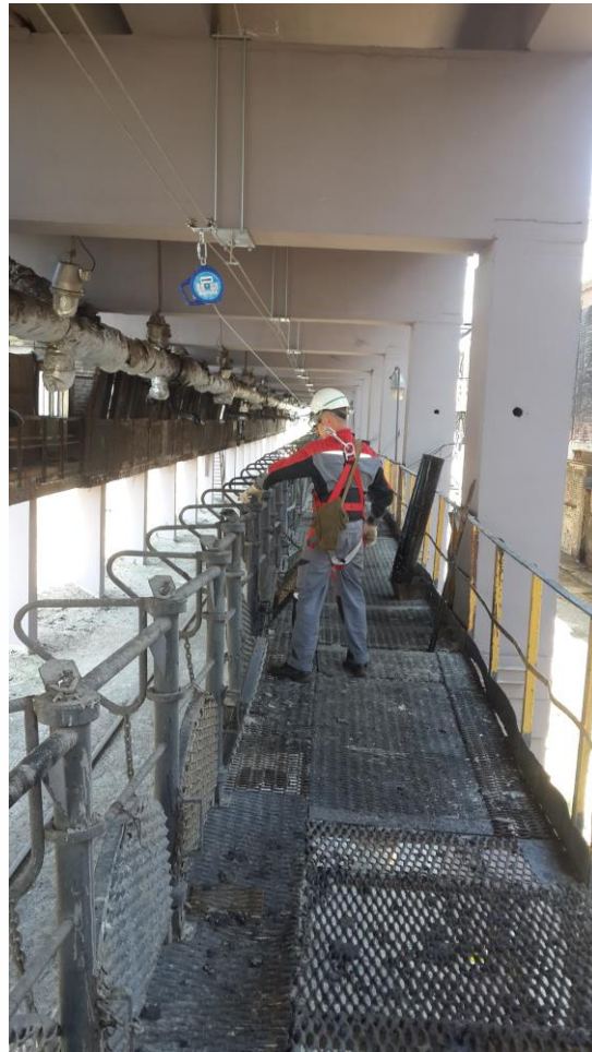
Гибкая анкерная линия Safetroll, смонтированная в обхват балок существующих конструкций.
