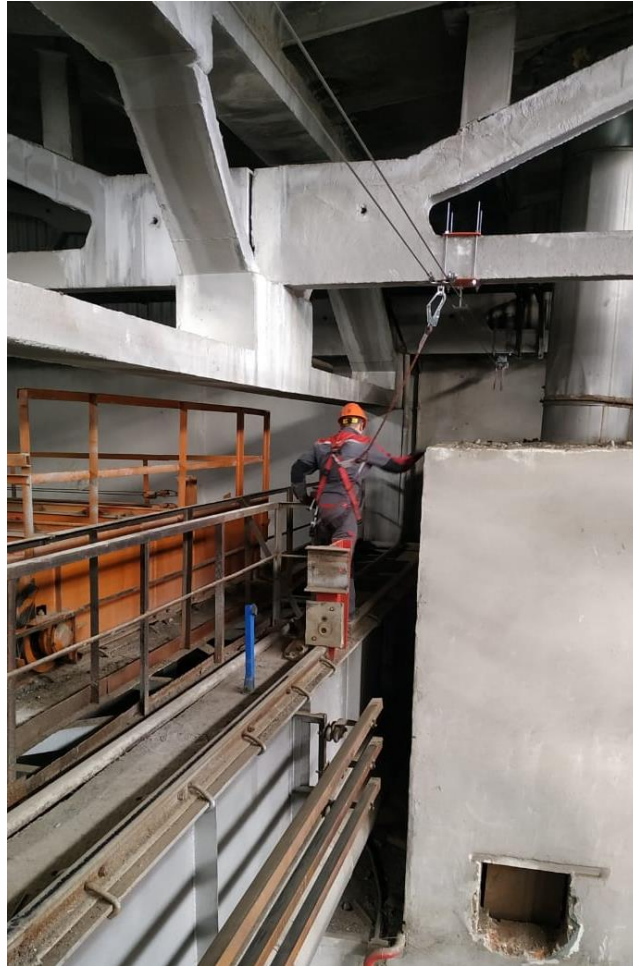
Стационарная страховочная система обеспечения безопасности высотных работ Гибкая анкерная линия Safetroll
