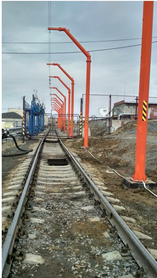
Гибкая анкерная линия Safetroll смонтированная на Г-образных опорах. Эстакада открытого типа
